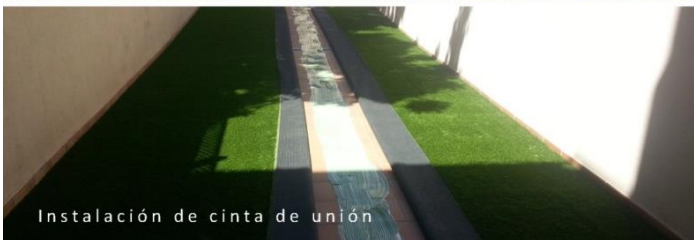
Instalación de césped
